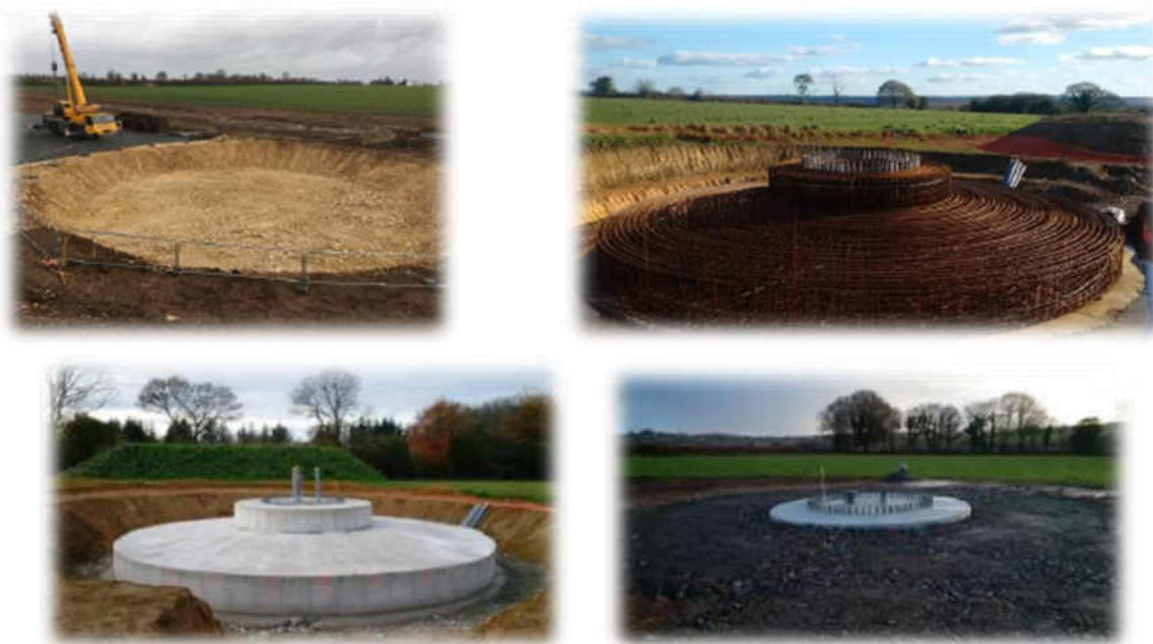
Figure 16 : Mise en œuvre d'une fondation (Source : ENERCON)
